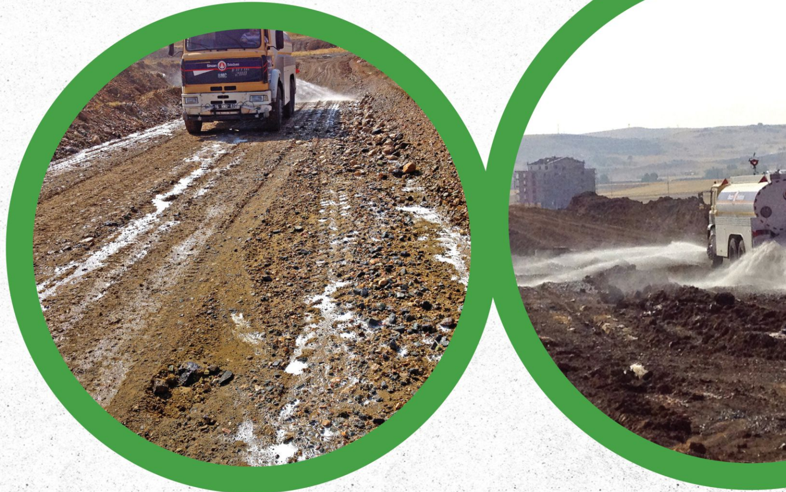
DOĞAL BETON SEYRELTE TABLOSU-EKLENECEK SU SIKIŞTIRMADA İDEAL NEME ULAŞMAK İÇİN SU GEREKLİ
